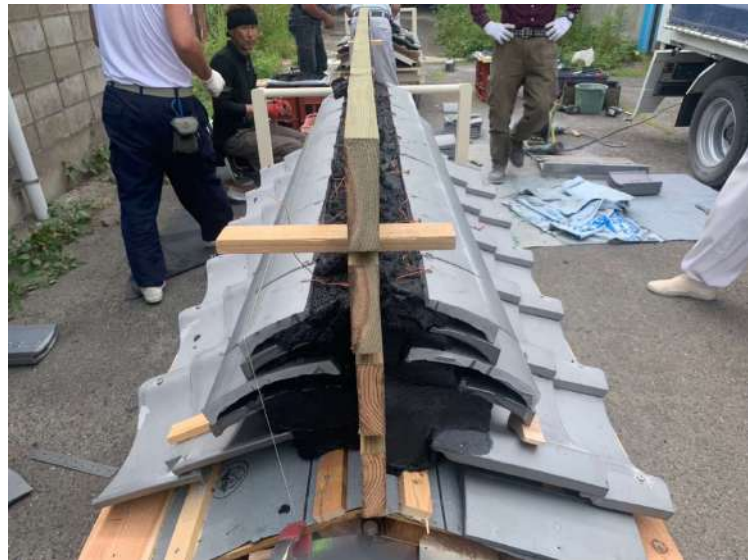
第三架台簡易箱棟工法スワロー仕様 4
