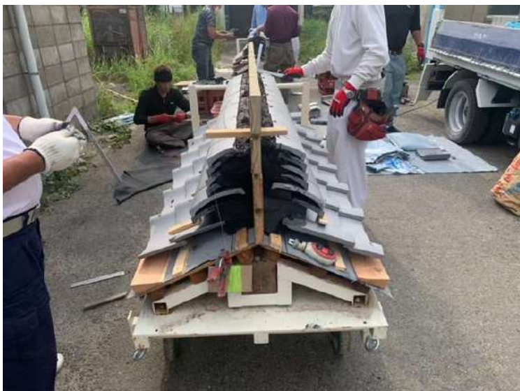
第三架台簡易箱棟工法スワロー仕様 5
