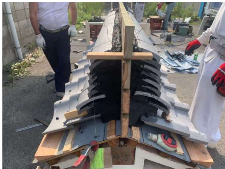
第三架台簡易箱棟工法スワロー仕様 6
