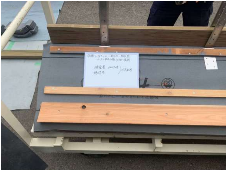
第三架台簡易箱棟工法スワロー仕様 1
