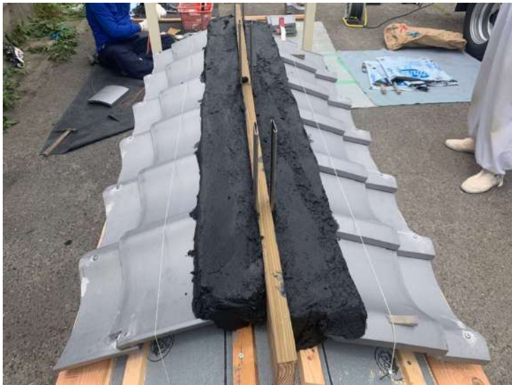
第三架台簡易箱棟工法スワロー仕様 3
